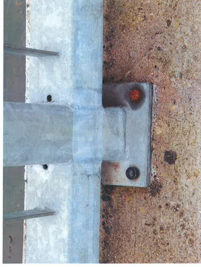
Koroze kotvících šroubů zábradlí
