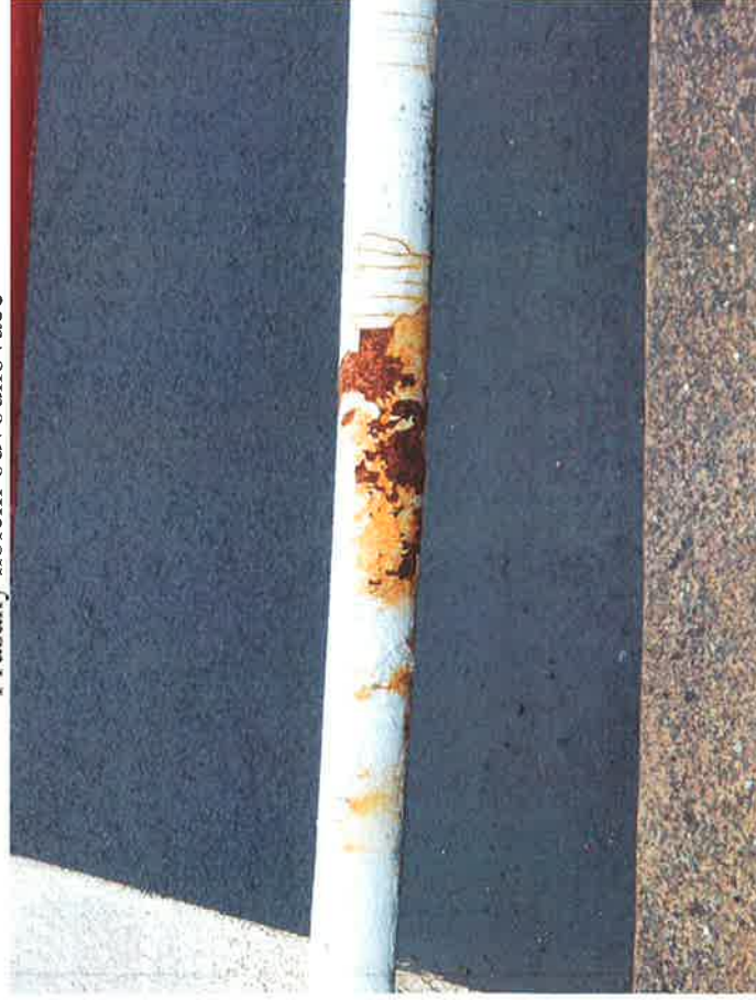
Poškozený nátěr a koroze zábradlí
