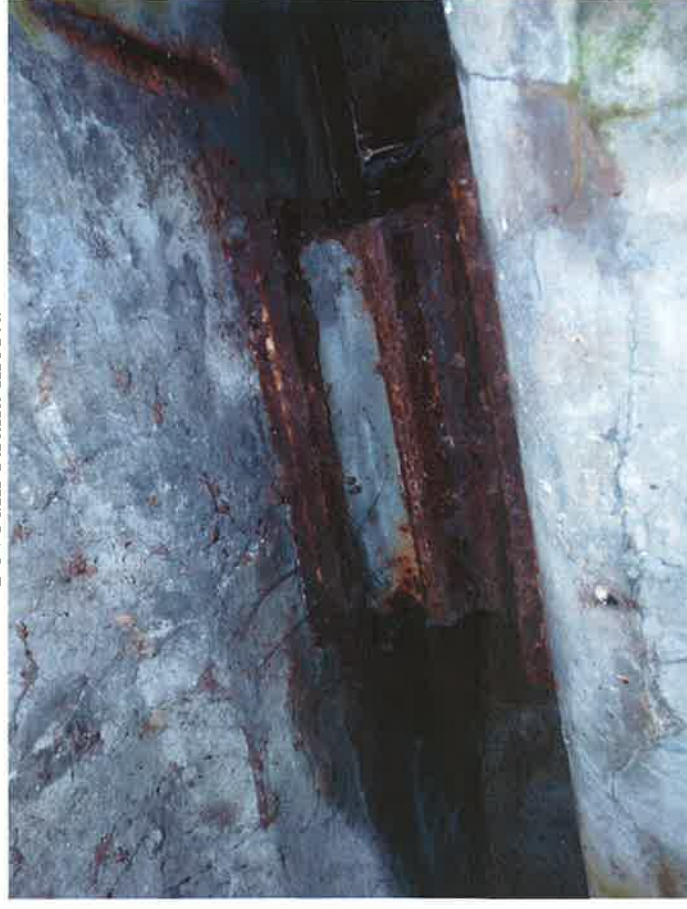
Koroze ložisek mostu
