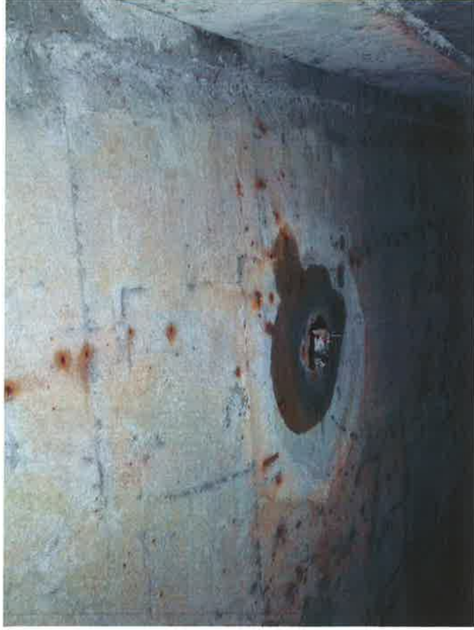
Průsaky kolem odvodňovače
